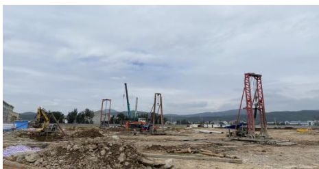
市五院迁建工程施工现场（9月28日）
